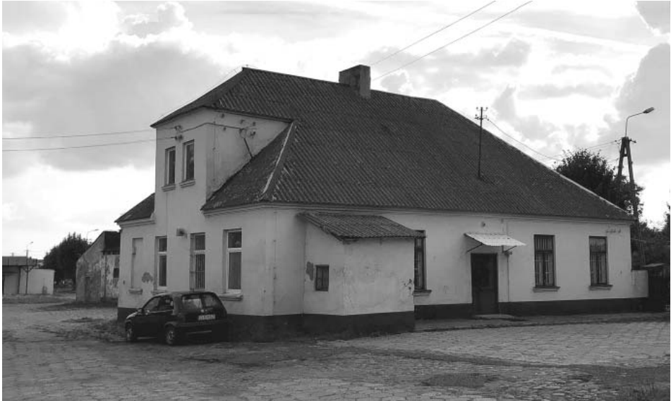
Budynek bet ha-midrashu i prawdopodobne mieszkanie rabina w sąsiedztwie grabowskiej synagogi, stan obecny (fot. Adam Sitarek)
